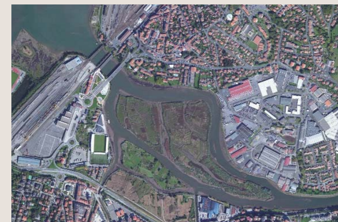
Les franchissements ferroviaires de la Bidassoa, qui marque la frontière entre France et Espagne.
