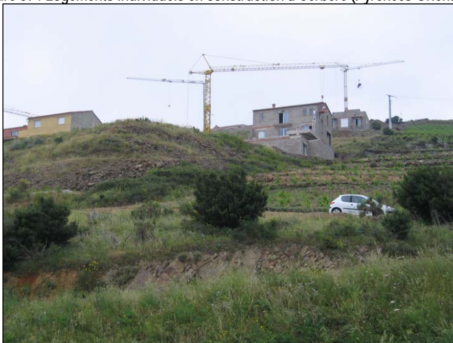
Figure 69 : Logements individuels en construction à Cerbère (Pyrénées-Orientales)
