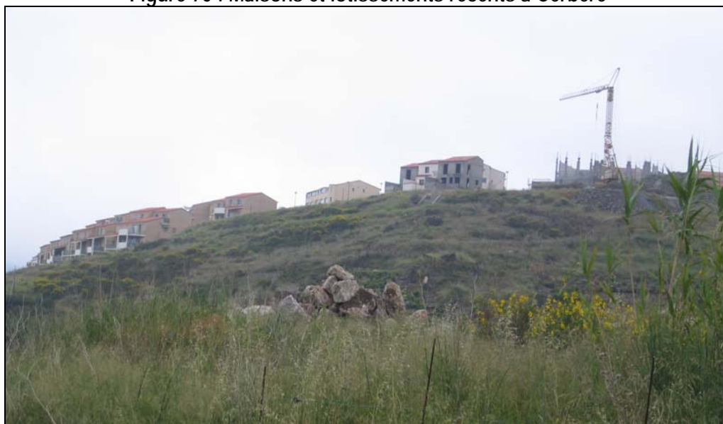
Figure 70 : Maisons et lotissements récents à Cerbère
