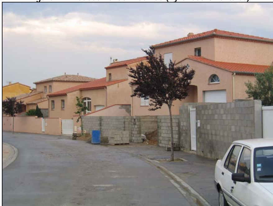
Figure 27 : Lotissement à Trouillas (Pyrénées-Orientales)
