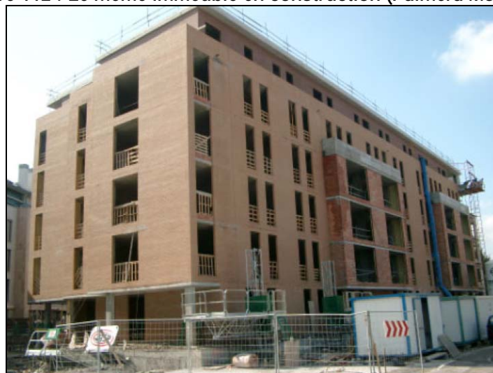
Figure 112 : Le même immeuble en construction (Palmera Montero)
