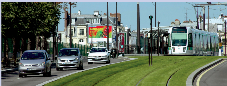
Soutenue financièrement par la Caisse des Dépôts/BDT, l'extension du tramway de Bâle à la gare de Saint-Louis côté français, a été inaugurée en décembre 2017.
