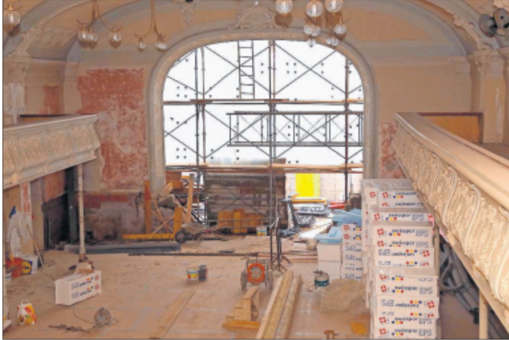
La salle rénovée de l'Inter (ici en chantier en 2013) sera inaugurée en avril. Le 9 mars, le public pourra déjà la découvrir lors de la conférence-débat du Forum transfrontalier.
