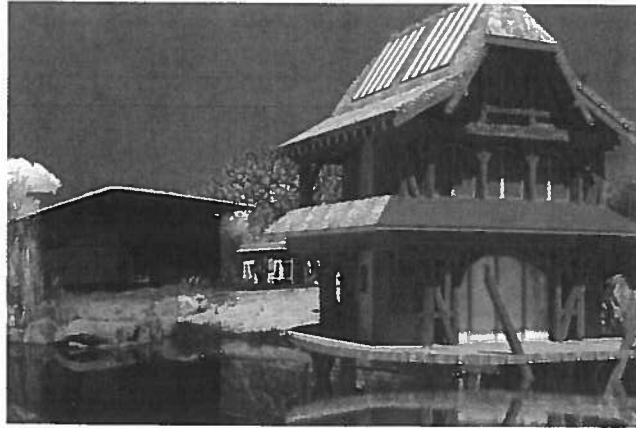
Le bâtiment reste le parent pauvre de la recherche et du développement. Et pourtant, le résidentiel fait quasi jeu égal avec les transports en termes de consommation globale d'énergie. Ecomusée d'Alsace. Maison alsacienne du 21 e siècle. Architecte : Mathieu Winter
