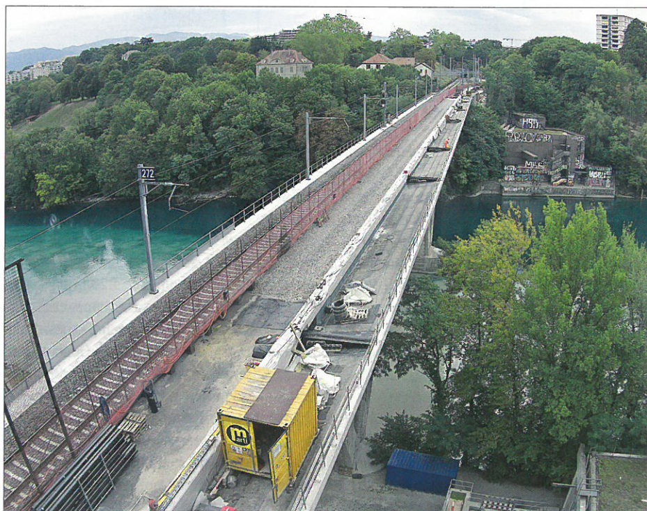
Travaux sur le viaduc de la Jonction avec voie amont transformée en voie unique (mai 2017).
