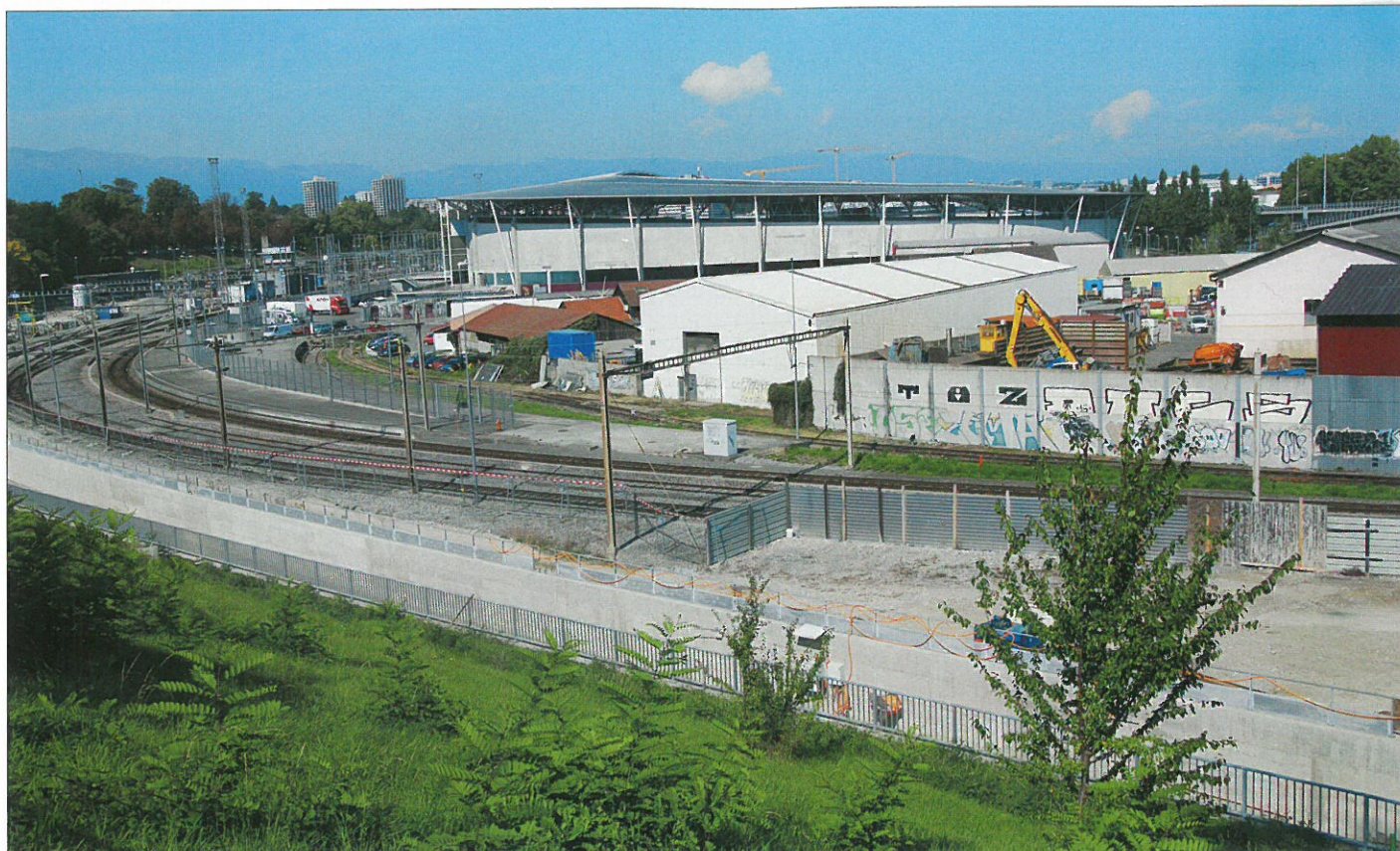
La gare semi-enterrée de Carouge Bachet avec les faisceaux marchandises de La Praille (23 septembre 2017).
