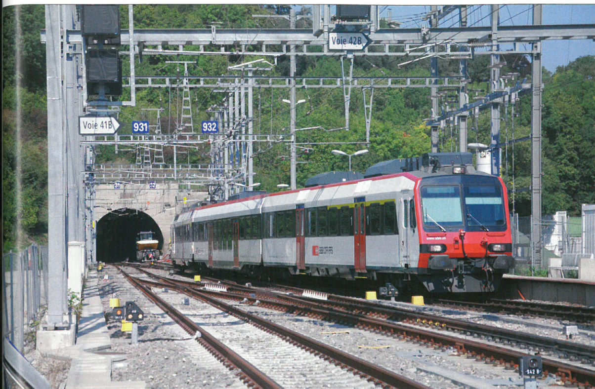
Ci-contre et ci-dessous : élément CFF venant de Coppet débouchant du tunnel de la Bâtie et arrivant à la halte de Lancy Pont-Rouge ; les deux voies Ceva dont déjà posées entre la gare d'Annemasse et la frontière, vues ici à l'entrée de la tranchée centrale (23 septembre 2017).
